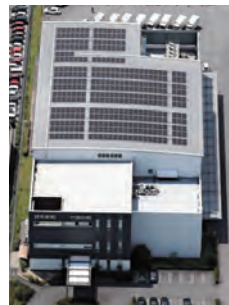
清須工場の太陽光発電システム
