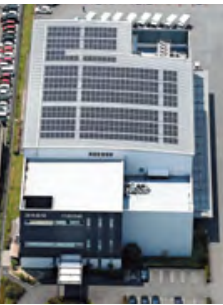
清須工場の太陽光発電システム
